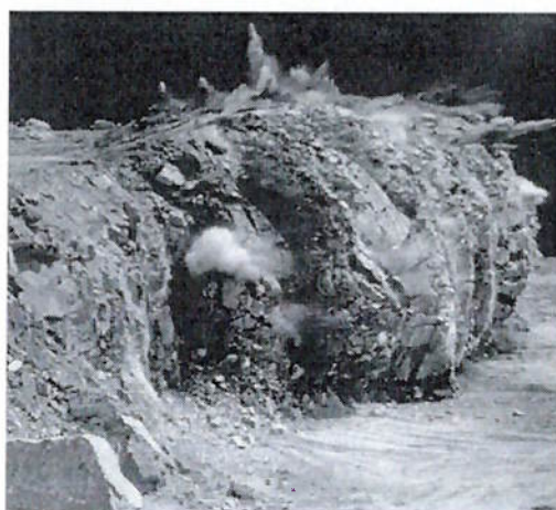
Figura 4 - Desmonte em bancada (OLOFSSON, 1990).
